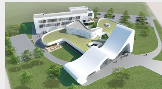
▲ Le Département achève la construction de l'ESTP.
