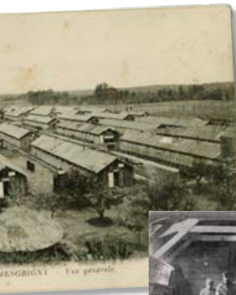
Hôpital de Mesgrigny. Rapides à monter et d'un confort et d'une longévité supérieurs aux tentes, les baraques Adrian pouvaient accueillir 73 lits.
